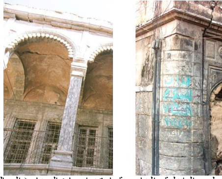
شكل رقم (10) : المعالجات الزخرفية والتشكيلية للسطوح الداخلية والخارجية باستخدام مادة الرخام ( الحياي ، 2005 ، ص73 )
